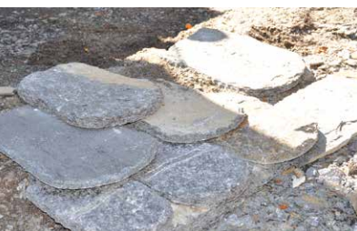
Les toitures en lauzes ont une durée de vie de plus d'un siècle
