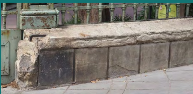
La reprise des chasse-roues et des entablements
