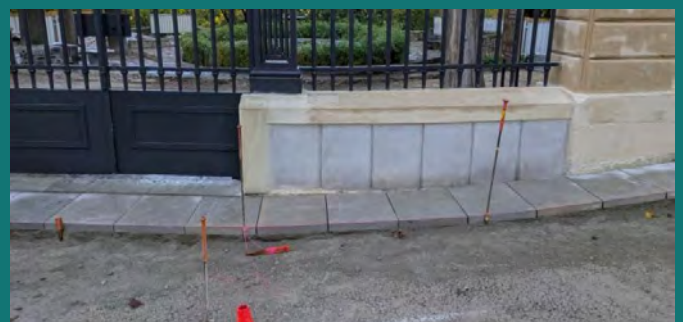
La reprise des chasse-roues et des entablements
